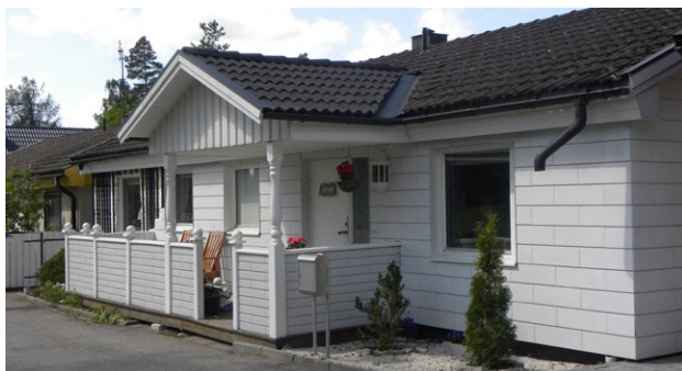
Verschobene Vertikalfugen
