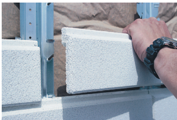
Marmoroc bei der Montage
